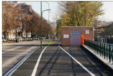
Il lungofiume con il fabbricato di controllo della centrale
