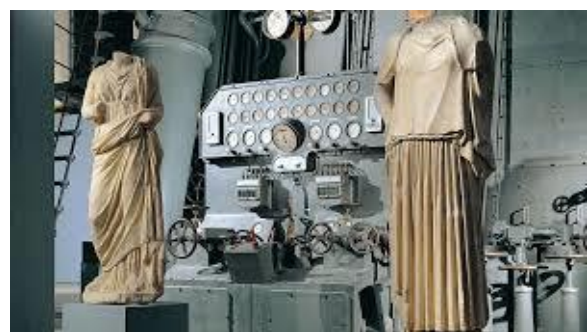
Particolare della Centrale Montemartini di Roma
